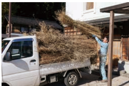
合掌造りの茅葺き屋根の補修と葺き替えには乾燥させた茅が大量に必要。秋に刈り取った茅をよく乾燥させて使う。
